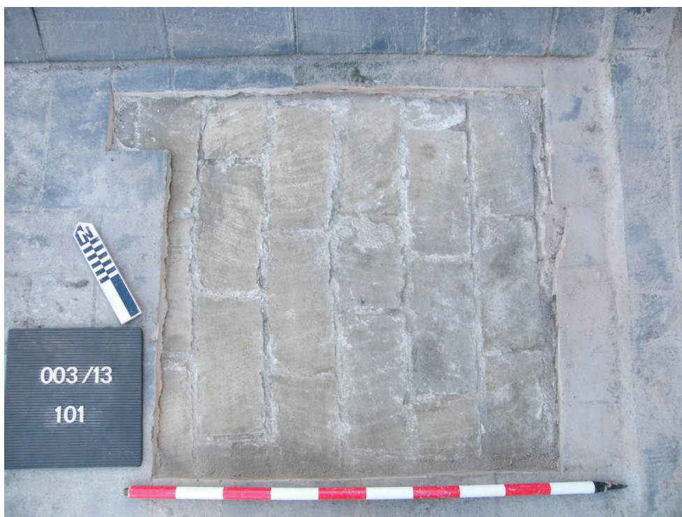
Fig.2 Podem observar la segona coberta de rajoles al trencajunt (UE 101)
